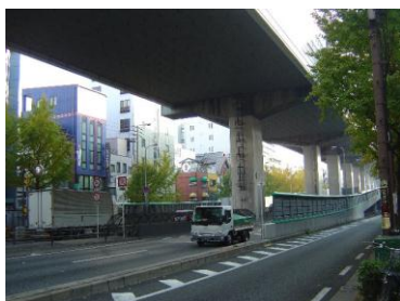
図-4 取替工事箇所状況
