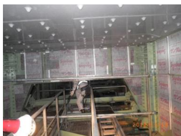
図-5 防振パネル設置状況(左:設置写真 右:設置モデル)
