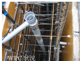
写真-2 PC 実施状況
