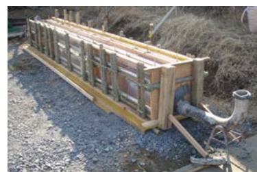
図-2 打設前型枠模型
