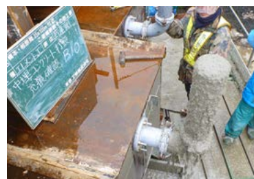
図-7 中埋コンクリート打設状況
