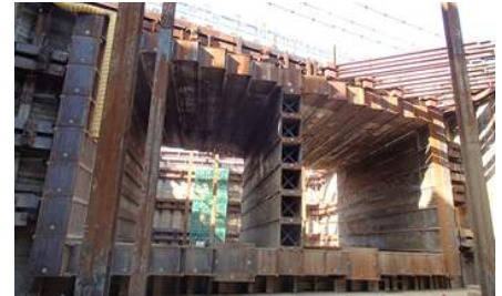
図-1 HEP&JES 工法による施工
