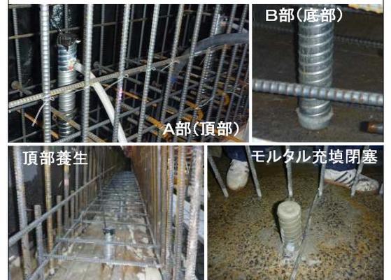
図-2 簡易パイプクーリング工法概要
