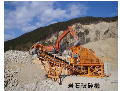
写真-4 栗石生産状況
