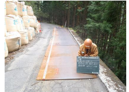
写真-3 道路整備状況
