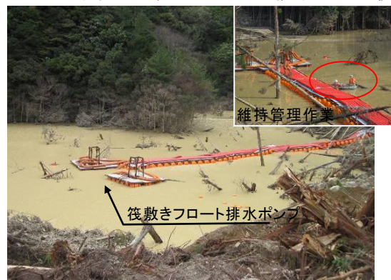
写真-6 下池排水状況
