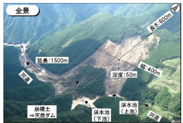
写真-1 熊野地区災害全景
