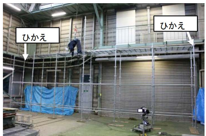
写真3 2層6スパンの足場
