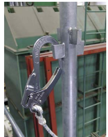
写真1 実験対象とした足場のくさび取付穴
