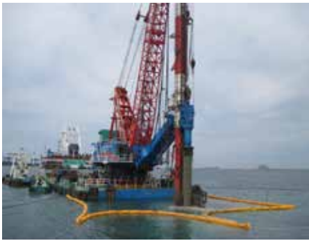
図-4 杭打設状況全景
