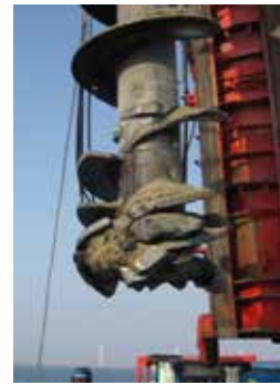
図-5 杭先端ビットおよび中掘りオーガー
