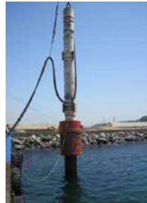
図-7 衝撃載荷試験状況
