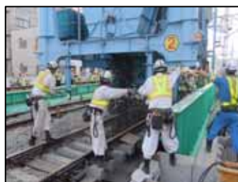
写真 - 9 バラスト投入
