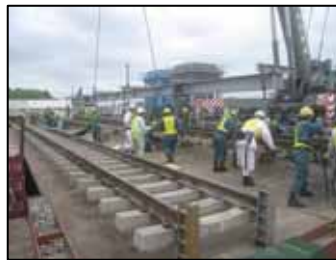
写真 - 5 軌きょう据付
