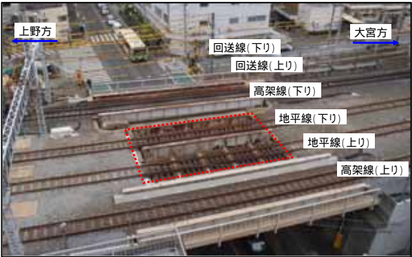
写真-1 現場全体
