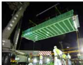
写真 - 7 新桁架設
