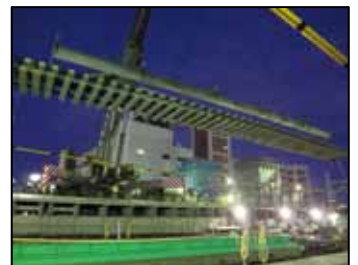
写真 - 8 軌きょう吊り込み
