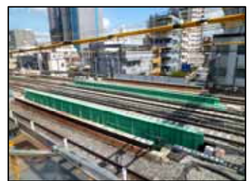
写真 - 10 施工完了
