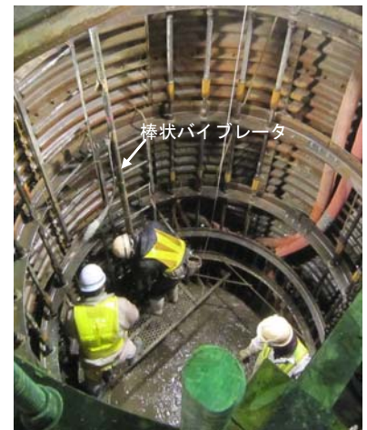
写真-2 締固め状況
