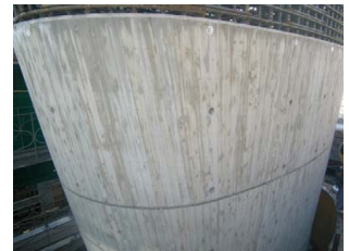
写真-4 P4 橋脚
