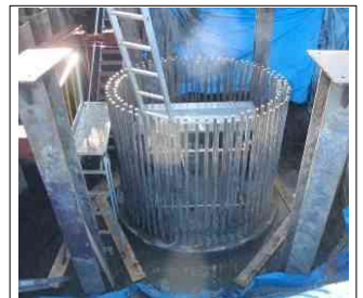
写真2 杭打設完了状況
