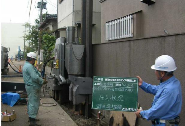
写真 -1 遮断壁工の施工状況
