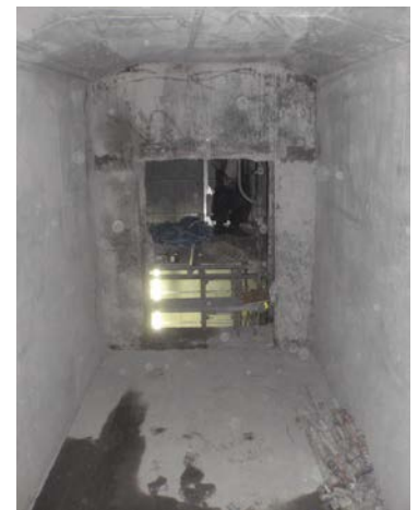
写真-4 横坑完成写真
