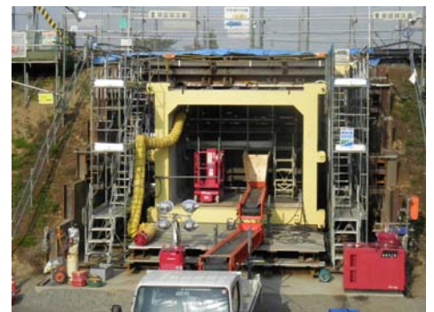
写真-1 函体牽引状況
