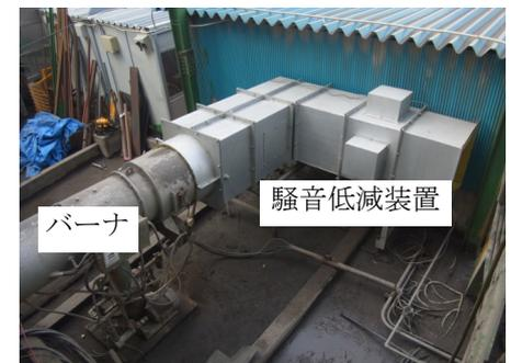
写真-2 騒音低減装置の設置状況
