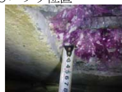
図-4 側壁の損傷状況とコア採取及びハツリ位置
