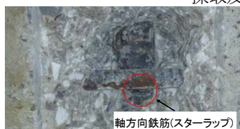
図-4 側壁の損傷状況とコア採取及びハツリ位置
