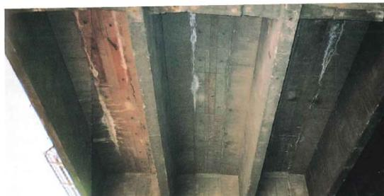
図-2 補強前の損傷状況
