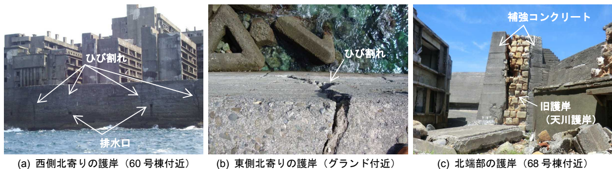
写真-1 護岸の外観と損傷状況の例
