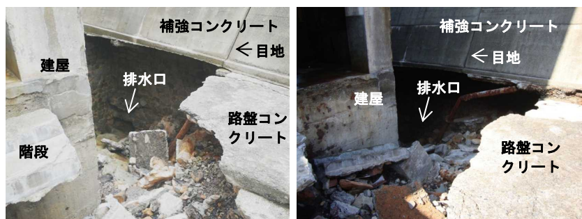
写真-1 護岸の外観と損傷状況の例
