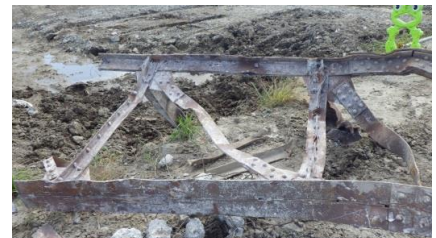
写真-3 管理橋内部の鉄骨
