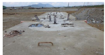
写真-4 堰柱基部上面の配筋状況
