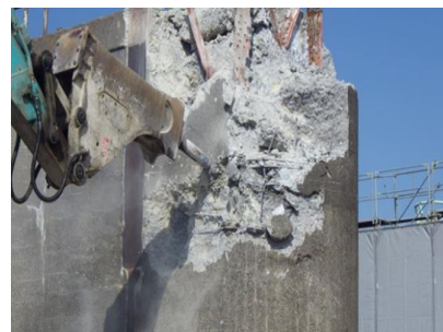
写真-2 堰柱解体の様子
