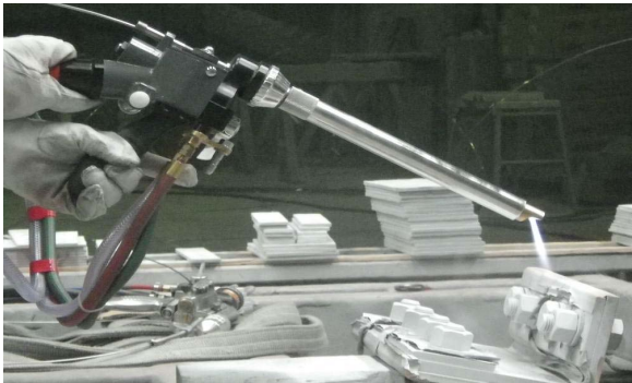
写真-4 狭隘溶射ガンの施工状況
