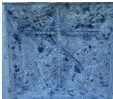
写真-1 内部鋼材状況 (事前はつり調査)
