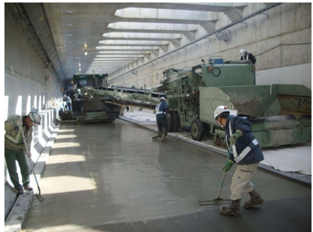
写真-2 付着材塗布状況
