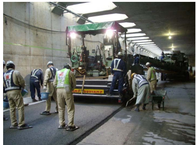
写真-3 POC 舗設状況
