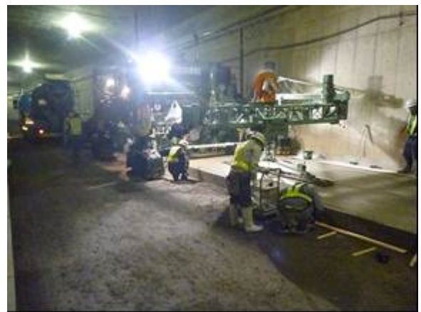
写真-1 CRCP 舗設状況
