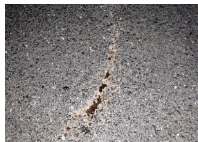
写真-2 轍の凹みのひび割れ
