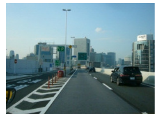
写真-9 交通開放状況
