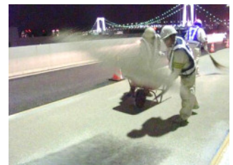
写真-7 白色遮熱骨材散布
