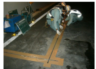
写真-4 グース温度計設置
