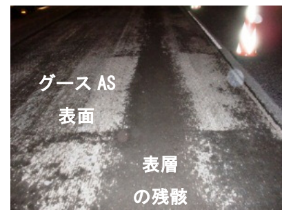
写真-3 轍の底の表層の残骸
