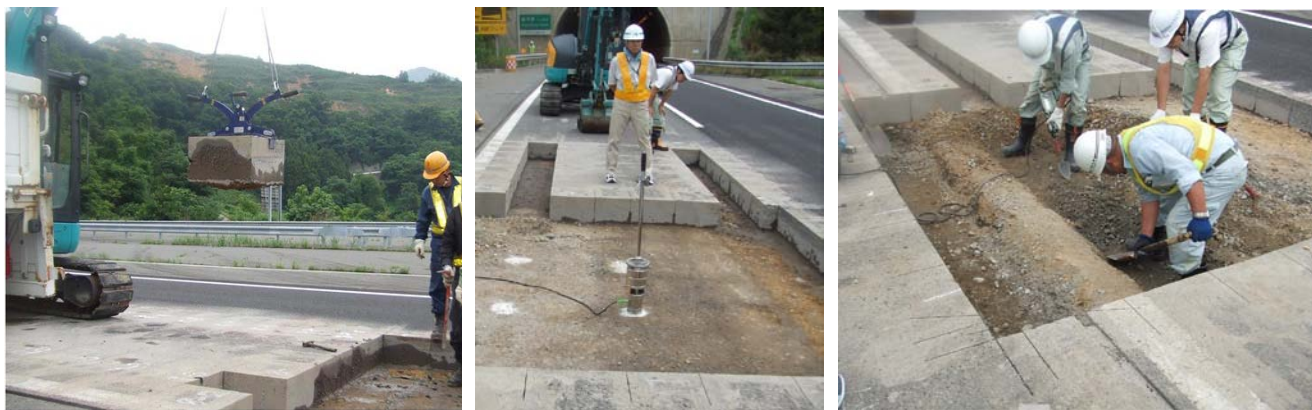
写真-1：(左)アスコン層の切出し (中)小型FWDによる路盤調査 (右)下層路盤材の採取状況
