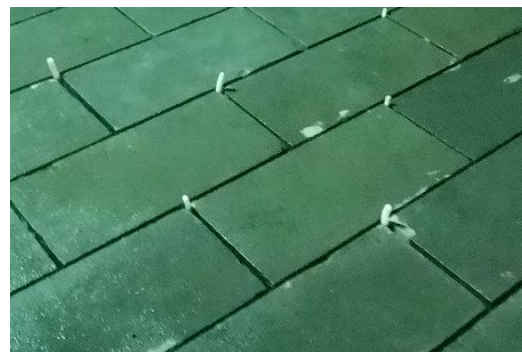
写真-1 棒状の発泡ポリエチレンの設置状況
