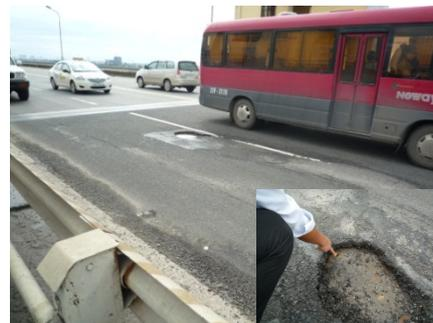
写真2 ハノイ市内近郊及びタンロン橋上の道路舗装損傷状況
