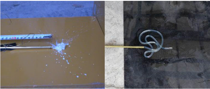
写真-2. 止水補修材の突出状況（左：A 材、右：B 材）
