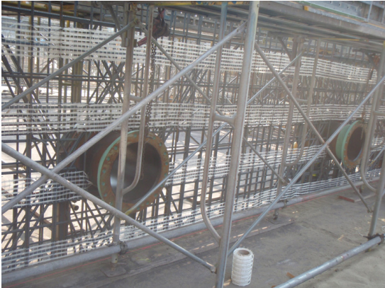
写真-1 繊維ネット取付け状況
