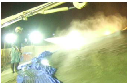
写真-2 散水状況
