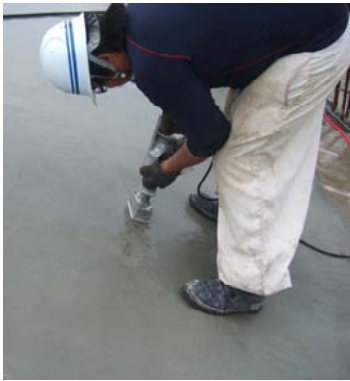
写真-1 ひび割れ修正状況
