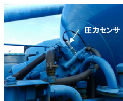
写真-1 圧力センサ設置状況
