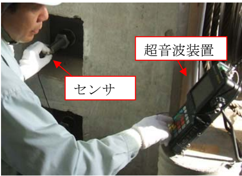
写真2 超音波法による損傷探査状況
