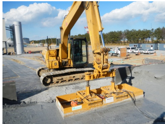
写真-1 締固め状況
