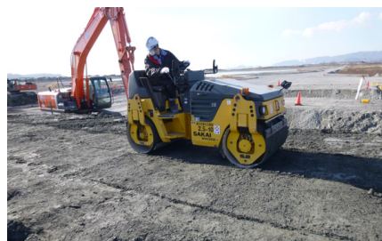
写真-2 転圧状況
