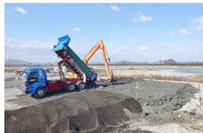
写真-1 盛土造成状況
