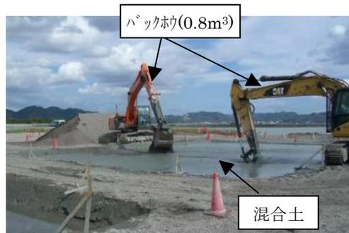
写真-2 バックホウでの混合状況
