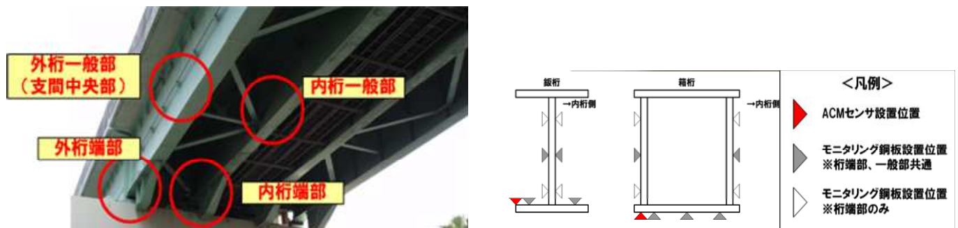
図 1 ACM センサ、モニタリング鋼板および温湿度センサの設置位置
