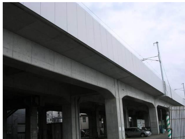
図-1 鉄道高架橋での FRP 高欄設置例
