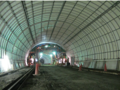
図-3 覆工内部温度の測定値 図-4 坑内温湿度および覆工内部湿度の測定値 写真-1 養生台車設置状況
