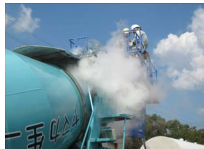
写真-1 液体窒素噴入状況
