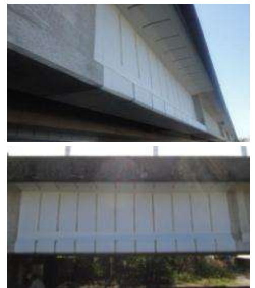
写真－2 施工後の状況
