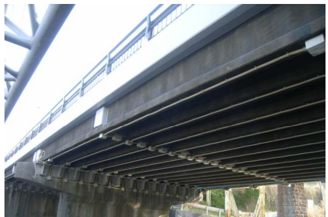
図-6 施工後の状況
