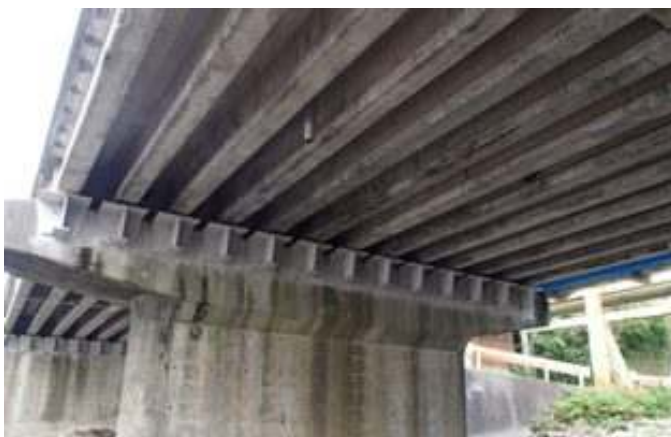
図-5 施工前の状況
