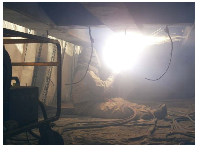
図-4 チタン溶射状況
