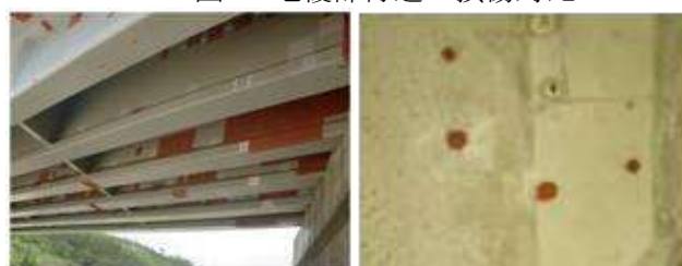
(a) 断面修復 (b) コア孔補修
