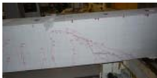
写真-4 Case-10 の破壊状況
