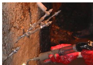
(c) 無機系止水材注入
