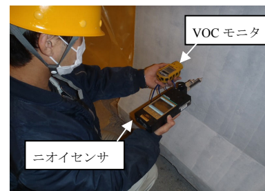
写真-1 臭気・VOC 濃度計測状況
