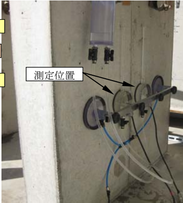
写真-2 表面吸水試験の状況
