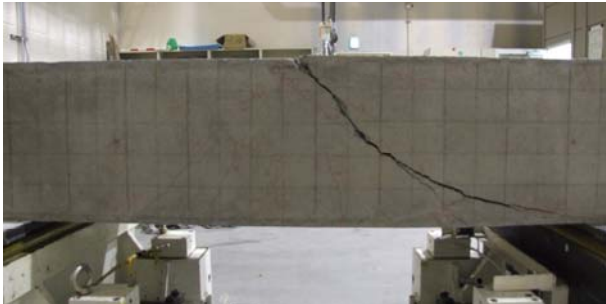
写真-3 B0-3 破壊状況（側面）
