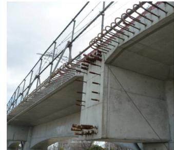
写真-1 施工打継目の例
