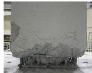
図-4 載荷終了後の鋼板内の く体の損傷状況(R-1)
