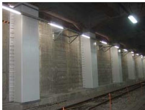
図-6 三面巻き補強の施工状況
